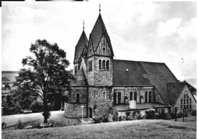
Unsere Pfarrkirche mit Erweiterungsanbau, der dann auch unten unser Pfarrheim ermöglichte. Bis dahin war die „Linde“ für uns eine hervor- ragende Starthilfe.
